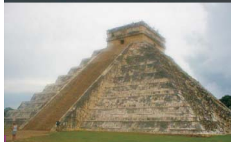
Ο Παρθενώνας στην Ελλάδα και το Chitcen Itza στο Μεξικό ανήκουν στα μνημεία που έχουν υποστεί καταστροφές εξαιτίας της όξινης βροχής.
